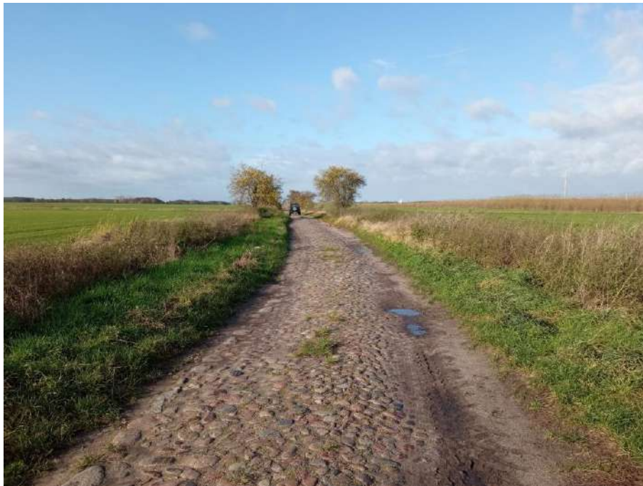
Abbildung 3: Flurstück 79, östl. Abschnitt, Blick Richtung Nordwesten (14.11.2023)
