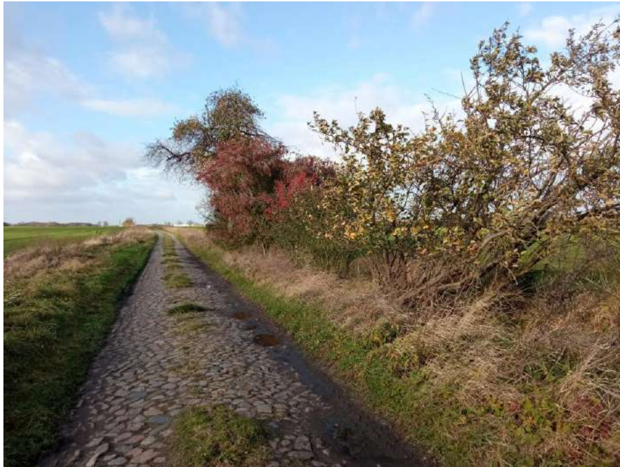
Abbildung 7: Flurstück 79, mittlerer Abschnitt, Blick Richtung Nordwesten (14.11.2023)
